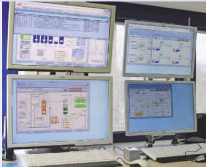
Die Gebrauchtlösemittel tanks von Roche Diagnostics werden von einem eigenen Regieraum aus überwacht, in dem Echtzeitinformationen über die Füllstände und eventuelle Gefahrensituationen eingehen
