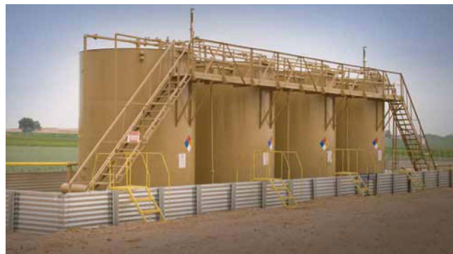
Рис. 5. Когда сырая нефть хранится в резервуарном парке, вероятность выделения паров в атмосферу очень высокая. Система получения паров, которая относится к поршневому газовому компрессору Blackmer, может захватывать эти пары и работать с высокой надежностью и дополнительными годовыми доходами
