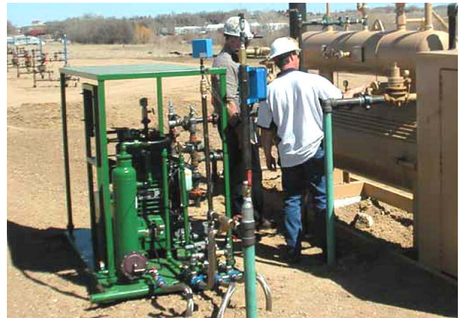
Рис. 4. В конструкции компрессора Blackmer предусмотрено приспособления для контроля небольшого количества конденсата, накапливаемого в зоне компрессора, называемой камерой с дистанционным кольцом
